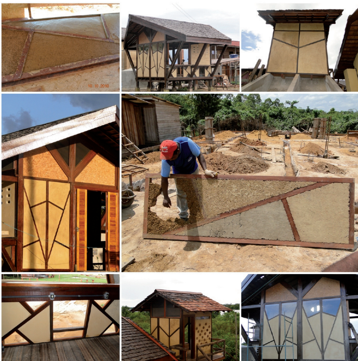
Figura 4 – Registro fotográfico da execução da taipa leve (painéis de solocimento e serragem de madeira) durante construção da Base Administrativa da Reserva Biológica do Lago Piratuba localizada na cidade de Cutias/AP.
