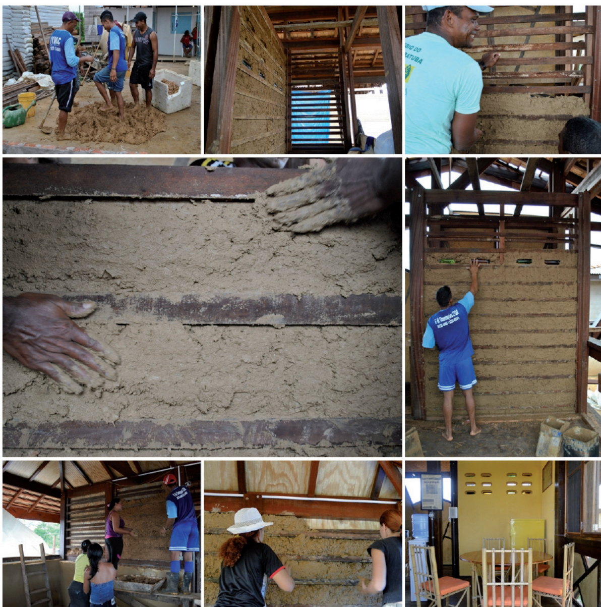
Figura 5 – Registro fotográfico da execução da taipa de mão (pau-a-pique) durante construção da Base Administrativa da Reserva Biológica do Lago Piratuba localizada na cidade de Cutias/AP.
