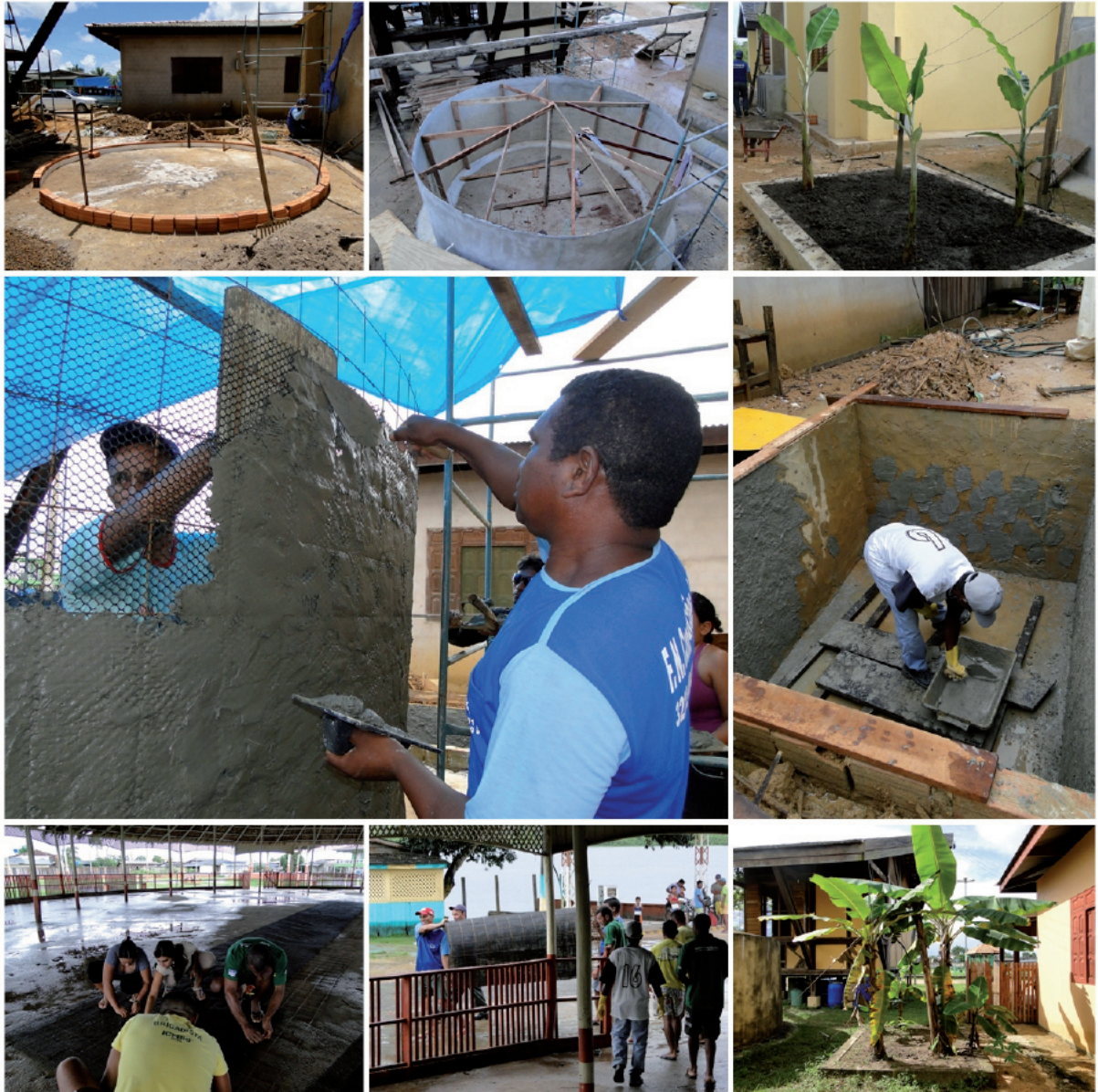
Figura 7 – Registro fotográfico da construção da cisterna de ferrocimento e fossa com utilização de bananeiras durante construção da Base Administrativa da Reserva Biológica do Lago Piratuba localizada na cidade de Cutias/AP.
